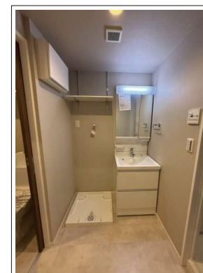
水回り施工例
